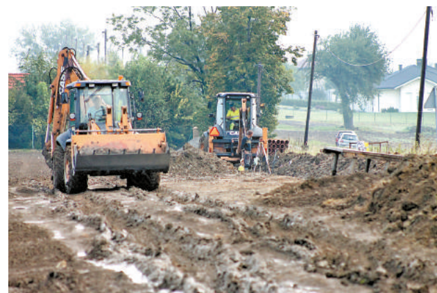
W ostatnim czasie prace związane z budową kanalizacji w gminie Dębowiec są prowadzone w Gumnach • Fot. Dorota Krehut-Raszyk
